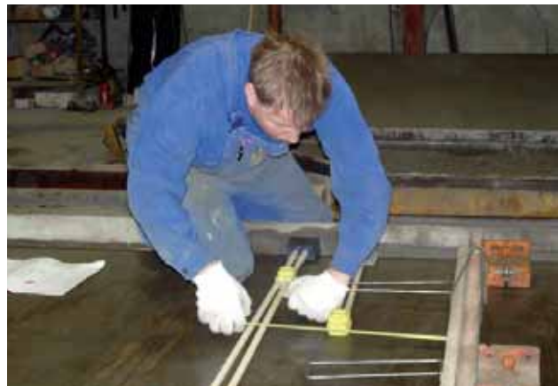
Figur 18. El-dåser, som er fastholdt til støbeformen med en magnet, måles ind og justeres.
