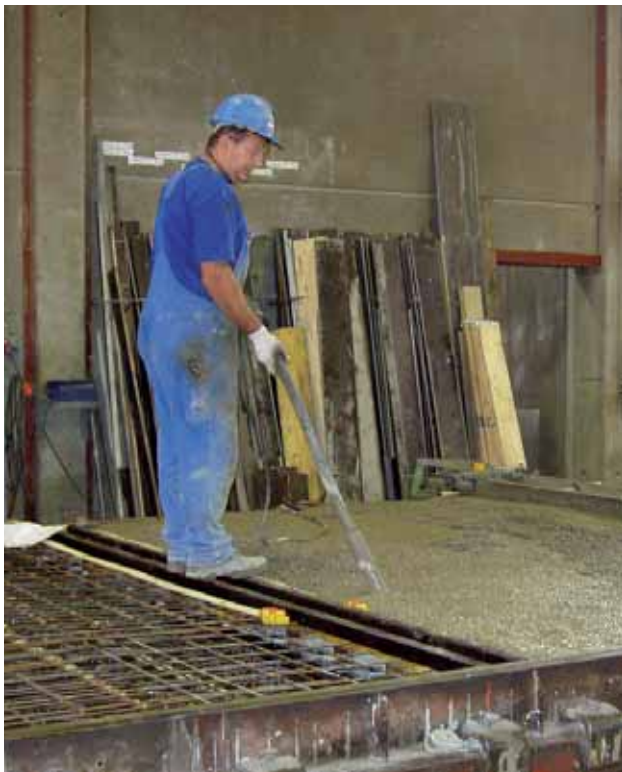
Figur 31. Efter udstøbningen komprimeres betonen ved vibration – her med en stavvibrator. Også her er der risiko for at indstøbningsdelene flytter sig, hvis fastgørelsen ikke er tilstrækkelig.
