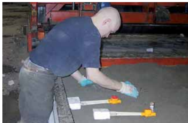
Figur 33. Ilægning af el i opsidens af et letklinkerbetonelement. Fremstillingsmetoden for vægge af letklinkerbeton medfører, at el-rør og dåser i opsidens først kan lægges i under selve støbeprocessen. Dåserne lægges i, inden formen fyldes helt op. Der opbygges en forhøjning af den jordfugtige letklinkerbeton, hvori dåse og rør lægges (»som at bygge sandslotte ved stranden«). Placeringen kontrolmåles.
