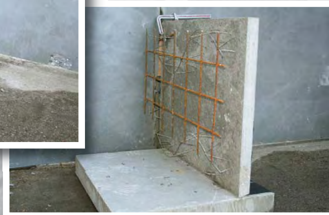
Filigranelement / element - Løsningsforslag til tætning af element/fundament med fredsring udført med Proofex 3000 og Proofex Detail Strip.
